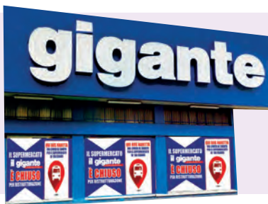
Copertura vetrine per lavori
